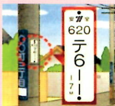
電柱の管理番号
